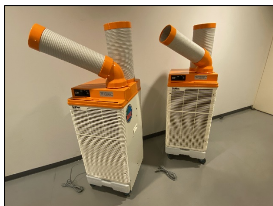
(3) スポットエアコン (2台)
